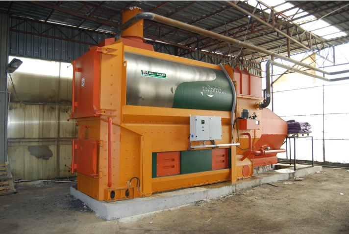
0-50 mm kömür yakmalı 2 Milyon Kalori / Saat kapasiteli kazanlar
